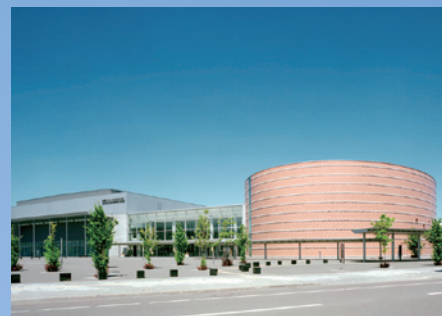
札幌コンベンションセンター
